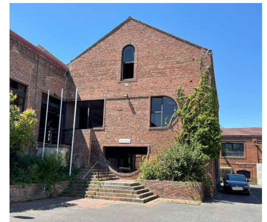
L'entrée de notre usine de Guise.
